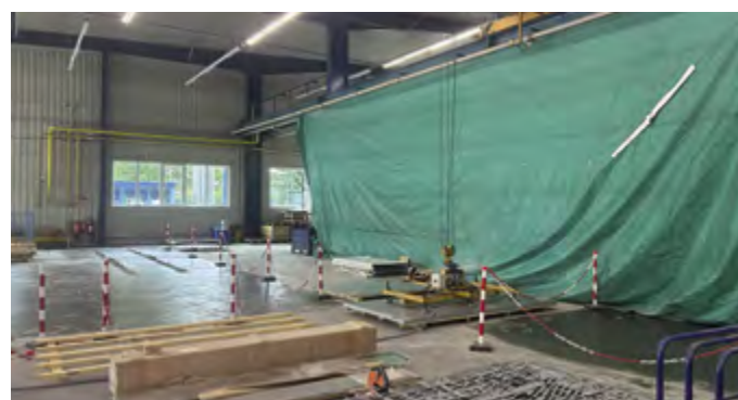
Časť výrobnjej haly na mechanické spracovanie konštrukčných plechov práve prechádza stavebnými úpravami a prípravami na príchod novej technológie – troch ohraňovacích lisov a deliaceho lasera so skladovým hospodárstvom,
